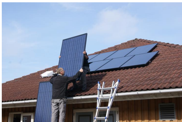
Solcellerne i Solhusene monteres
