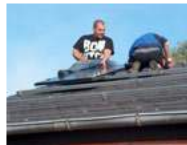
Opsætning af solceller på ældre tag.
